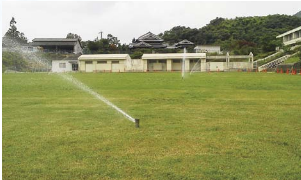
校庭 ポップアップスプリンクラー散水
