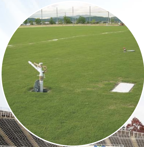
サッカー場 脱着式スプリンクラー散水
