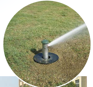
野球場 ポップアップスプリンクラー散水
