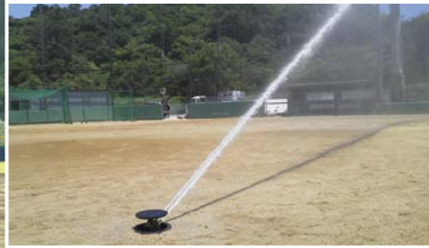
野球場 ポップアップスプリンクラー散水
