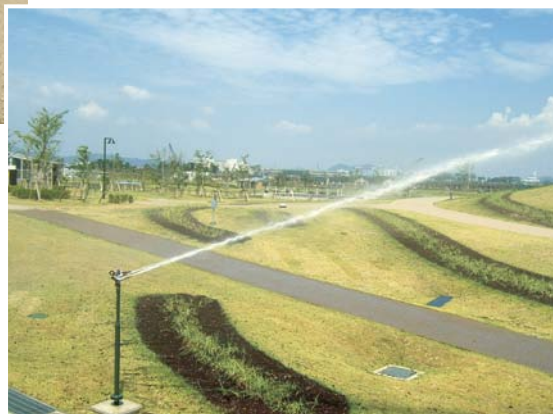
芝生 スプリンクラー散水(ハイボール立上り管)
